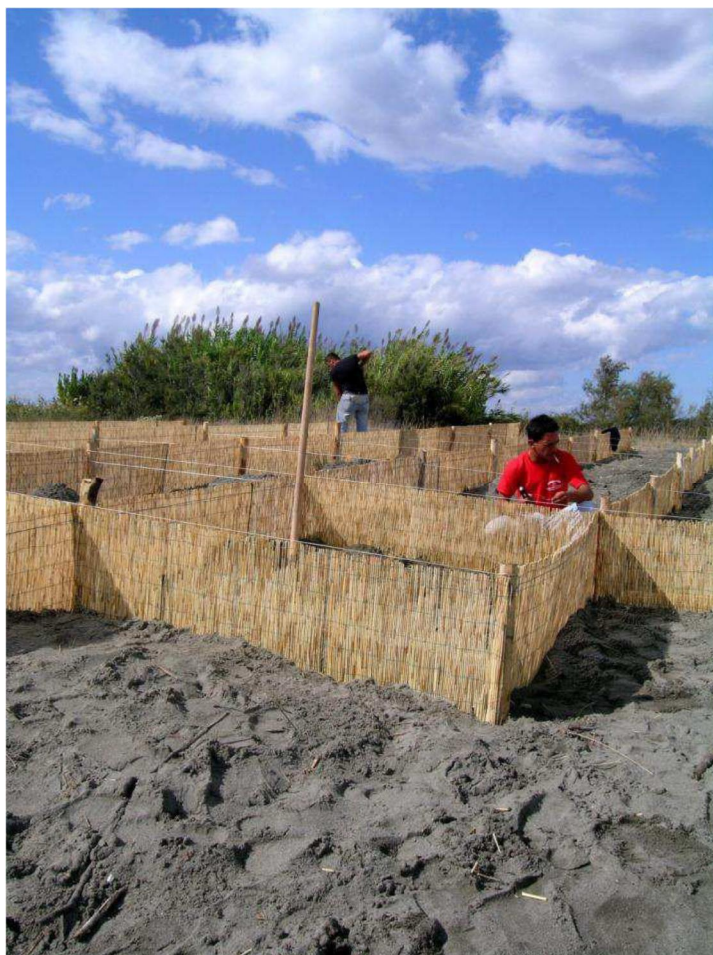
Figura 7 - Schermi frangivento a scacchiera in fase di realizzazione (Foto L. Forte)
