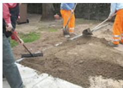
7) Aggiustamento con attrezzatura manuale del conglomerato terroso alla quota di pavimento finito.
