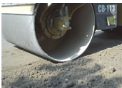
8) Compattatura della superficie vibrofinita con rullo compressore.
