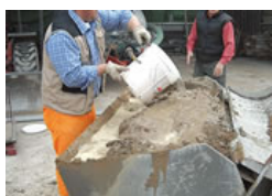
7) Aggiustamento con attrezzatura manuale del conglomerato terroso alla quota di pavimento finito.
