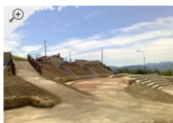
Piazzale in terra battuta stabilizzata Chiaromonte (Potenza)
