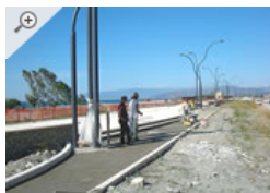
Lavori di realizzazione lungomare e pista ciclabile - Località Giovino Catanzaro Lido (Catanzaro)
